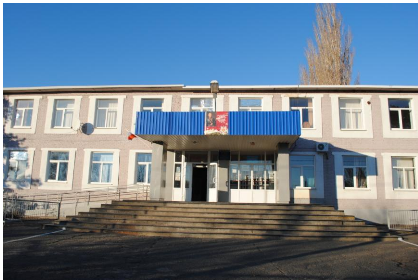
Здание школы №1 (ул. Мира д.26)
